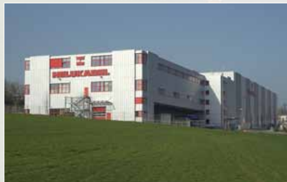
Logistik-Zentrum Hemmingen bei Stuttgart
